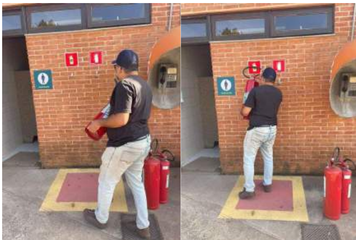
Figura 38: Troca de extintores
