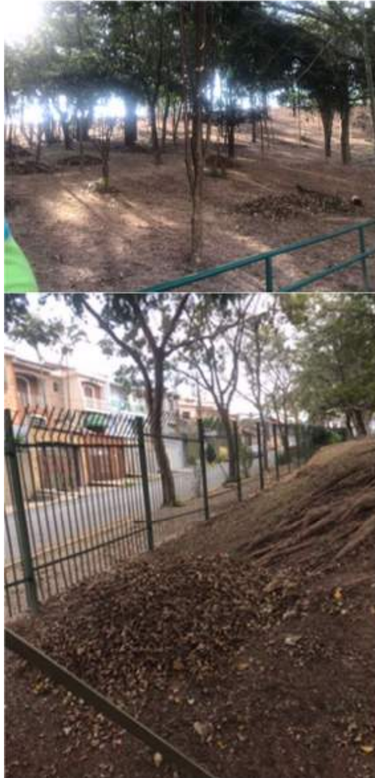
Figura 71: Rastelamento do talude
