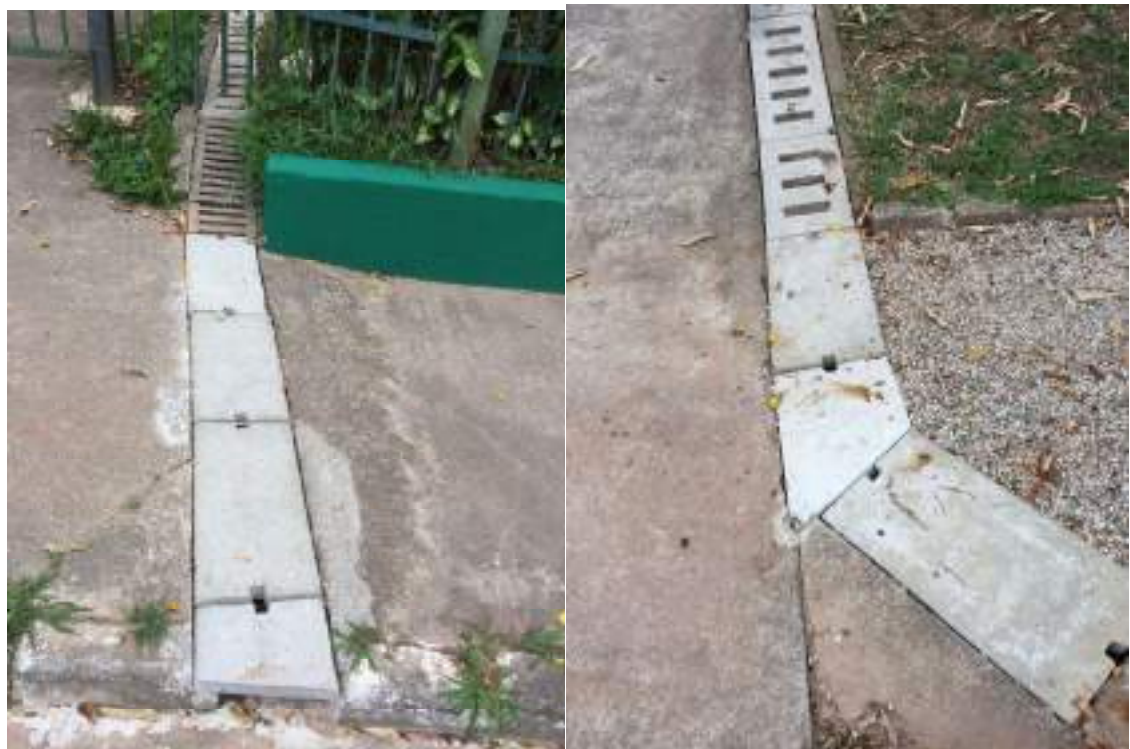
Figura 105: Instalação de tampas de grelhas
