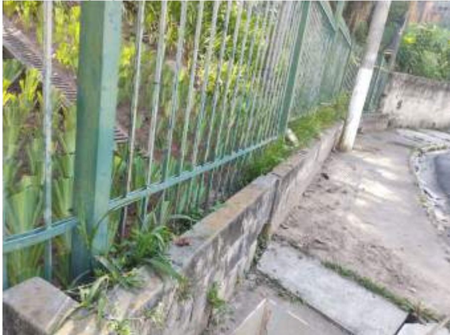
Figura 20: Despraguejamento de canteiro, ao lado do Portão 08 (antes)
