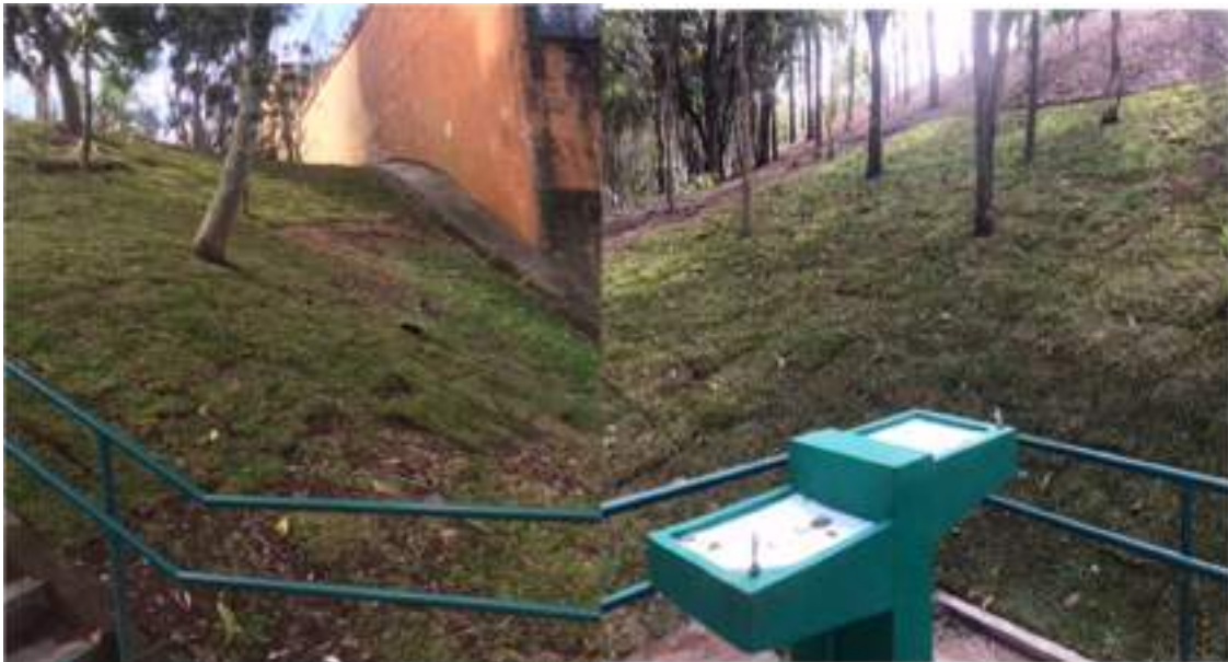
Figura 26: Grama plantada no talude
