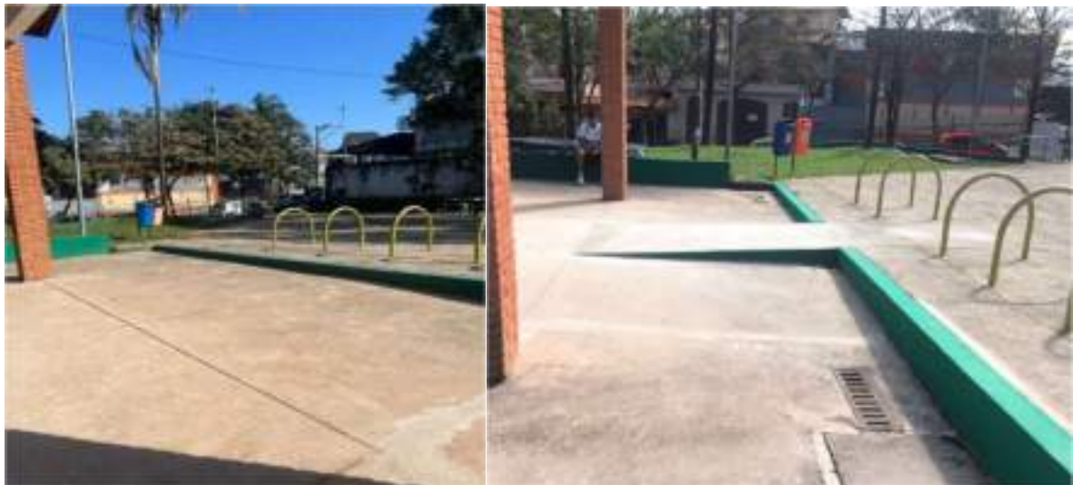
Figura 88: Instalação de rampa acessível no espaço multiuso
