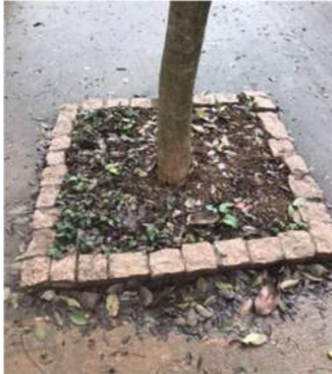
Figura 13: Reconstrução do canteiro em frente ao Portão 5 (antes)
