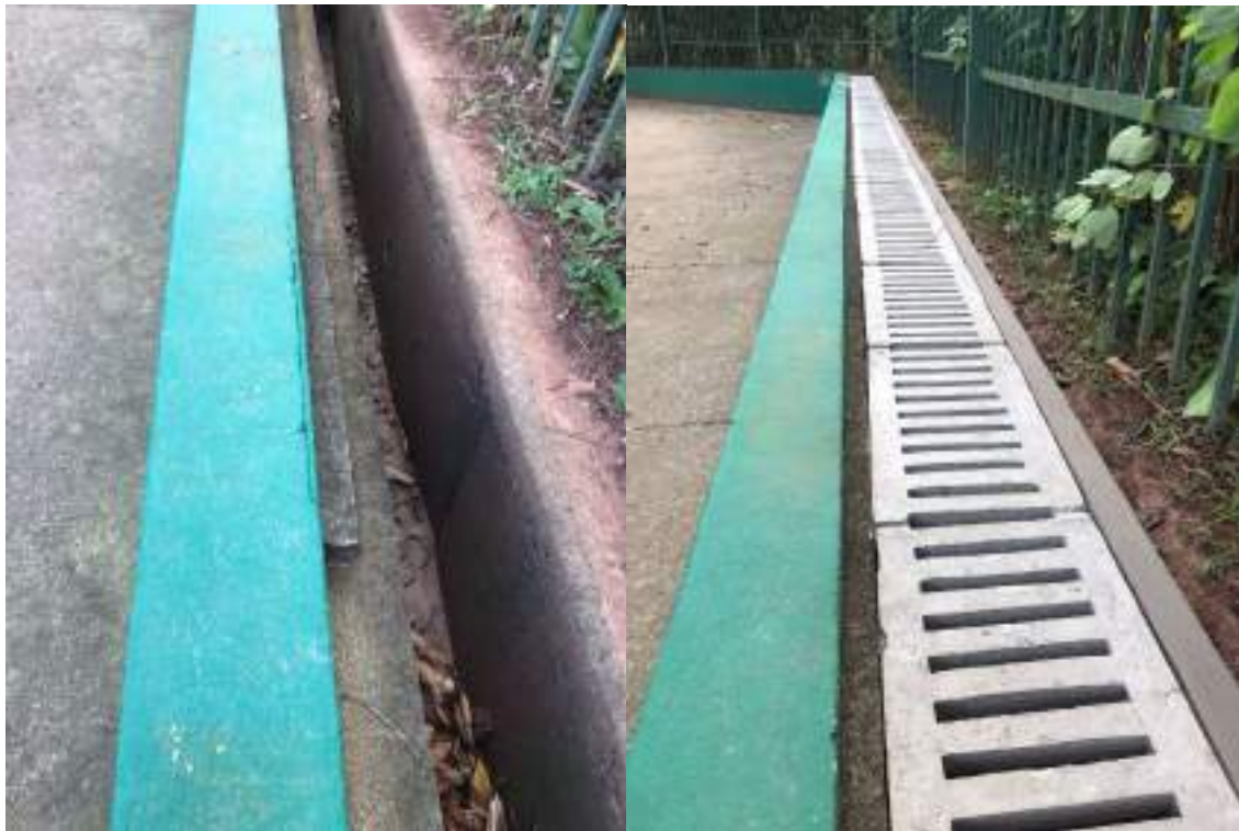
Figura 105: Instalação de tampas de grelhas
