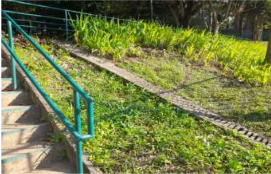
Figura 11: Reconstrução do canteiro em frente ao Portão 8 (antes)
