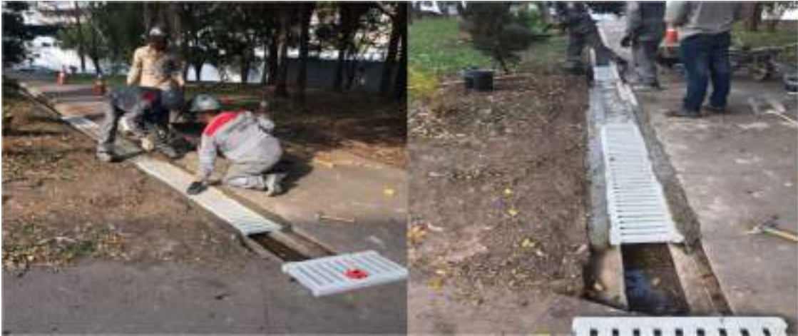
Figura 93: Troca das grelhas das canaletas
