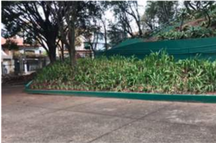
Figura 9: Reconstrução do canteiro ao lado do Portão 03 (antes)
